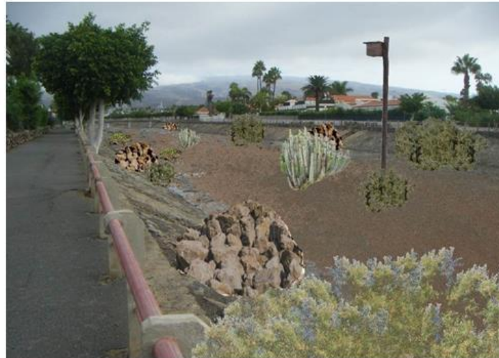
Simulación nº 2. Los tramos nº 2 y 3 son los tramos canalizados de los barrancos de Maspalomas y La Tabaguera. La renaturalización consiste principalmente en la demolición del pavimento de piedras y hormigón que recubre el cauce y el desarrollo de revegetaciones con especies autóctonas que recreen el paisaje natural originario de estos medios.
